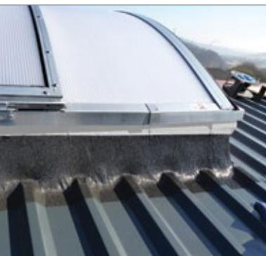
Dank der hohen Dehnfähigkeit ist Easy-Form® auch sehr gut zum Einfassen von Lichtkuppeln bei Trapez- bzw. Sandwichprofilen geeignet. Durch die farbbeschichtete Oberfläche passt sich das Anschlussband optisch an das Metallprofil an.
